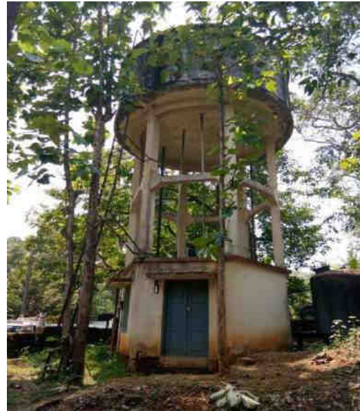
KWA Water Tank
